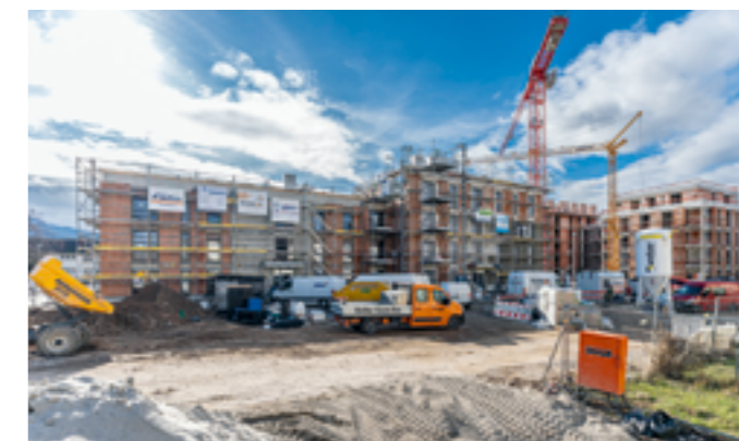
Eindrücke des ersten Bauabschnitts vom Februar 2024.
