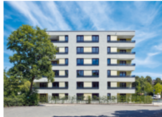
Neubau nebenan: Die fünf Neubau-Punkthäuser entstanden 2019/2020.
