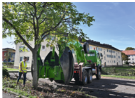
Vor Baubeginn: Baumverpflanzung von acht Bäumen auf das FSB-Grundstück Kirchacker.
